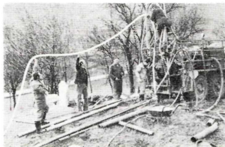
Obr. 10. Osadzovanie krehkých páskových vodičov — sondy SPV v ochrannej hadici z PVC do vrtu
